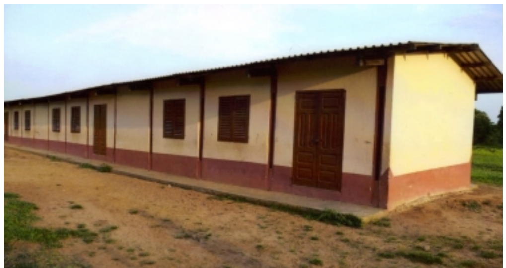
Die Schule nach der Renovierung
